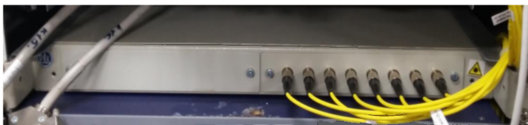
Рис. 55. Оборудование кросса оптического
